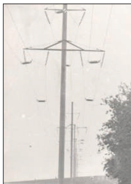
Foto 8. Stâlpi de linii electrice dirijate de clasa 110 kV, Bălți – Brânceni Noi, 1976–1977 [15, f.11].
