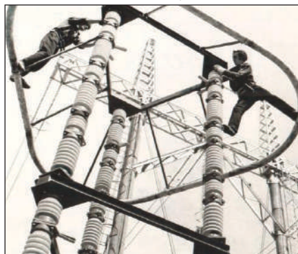
Foto 10. Montarea echipamentului de înaltă tensiune, 1988 [15, f.14].
